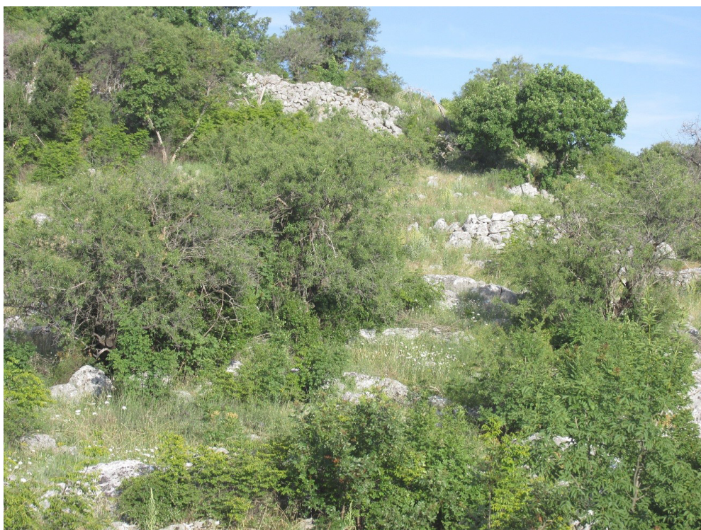
Sl. 7a i b. Potporni zidovi i grudobrani (foto: G. Glamuzina)
